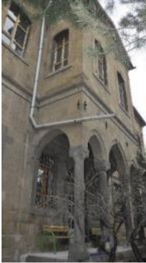
Foto 5- Dumlupınar İlkokulu batı cephe detay
