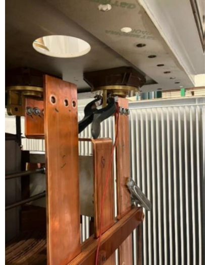
Şekil 6. Tij ile bara bağlantısı arasındaki ölçüm
