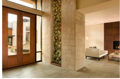
Şekil 12. Bardessono Otel lobisinde kullanılan arazideki eski yapının yeniden boyutlandırılmış tufa taşı ve sertifikalı ahşap malzeme [7]
