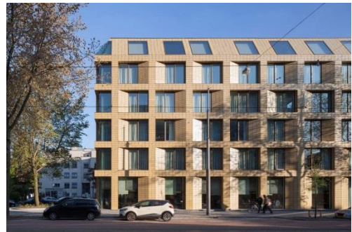
Şekil 3. Spinoza Otel'in doğal havalandırma ve aydınlatma amacıyla tasarlanan cephesi [21]
