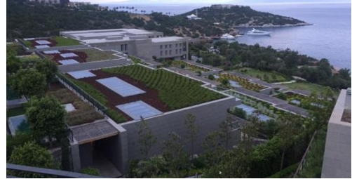
Şekil 2. Mandarin Oriental Otel'in yeşil ve serin çatı uygulamaları ile güneş panelleri için düz formulu tasarlanan çatısı [10]
