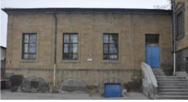
Foto 7- Dumlupınar İlkokulu ek bina
