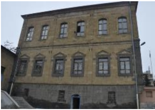
Foto 3- Dumlupınar İlkokulu güney cephe
