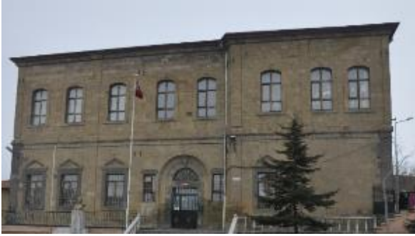
Foto 2- Dumlupınar İlkokulu doğu cephe
