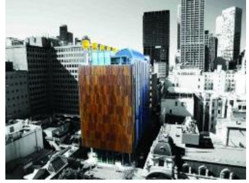
Şekil 6. Council House 2 Ağaç Kabuğu Gibi Tasarlanan Cephesi [14]
