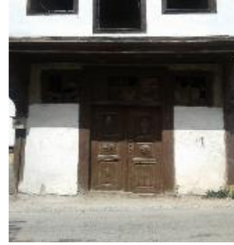
Şekil 2. Konut giriş kapıları
