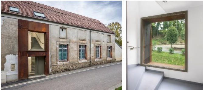
Şekil 15. Okuldan konuta dönüştürülen birimin okul yapısıyla ilişkisi ve yeni yapının cephe açıklıkları
