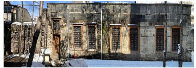
Şekil 7. Hacı Bekirzade Evi Batı Cephesi
