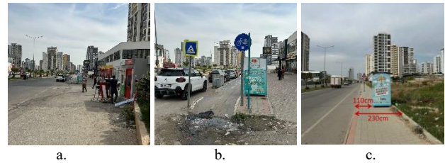
Şekil-18. 18-a: Yaya Kaldırımları ve Bisiklet Yollarının Kesintiye Uğraması, 17-8: Yaya Kaldırımları ve Bisiklet Yollarında Malzeme Bozuklukları ve Rampa Eğimi Hataları, 18-c: Yaya yollarında erişimi engelleyen yapıların bulunması. (Okur kişisel fotoğraf arşivi, 2024).
