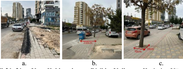
Şekil-21. 21-a: Yaya Kaldırımları ve Bisiklet Yollarının Kesintiye Uğraması ve Malzeme Bozuklukları, 21-b: Ağaç Türüne Bağlı Olarak Çanak Mesafelerinin Değerlendirilmeden Dikimi, 21-c: Ağaç Dikim Mesafelerindeki Yanlışlar. (Okur kişisel fotoğraf arşivi, 2024).
