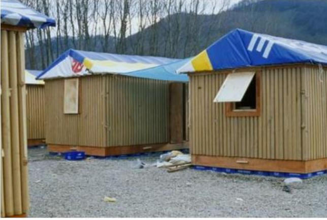
Şekil 4 1999 Marmara Depreminde kullanılan kâğıt tüp geçici birimler [34]
