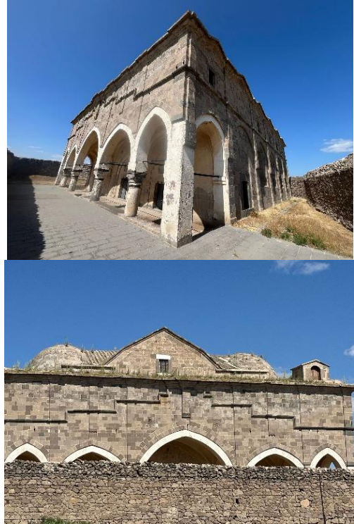
Şekil 5. Konaklı Rum Kilisesi üstte batıdaki narteks, altta ise batı cephesinin avlu dışından görseli
