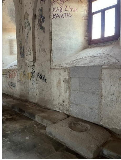
Şekil 12. Kilisenin duvarında oluşan taş kayıplarının tamamlanması
