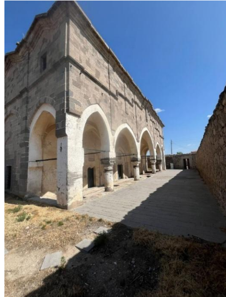
Şekil 13. Avlu kapısından kilisenin giriş kapısına kadar yapılmış olan taş yürüyüş yolu
