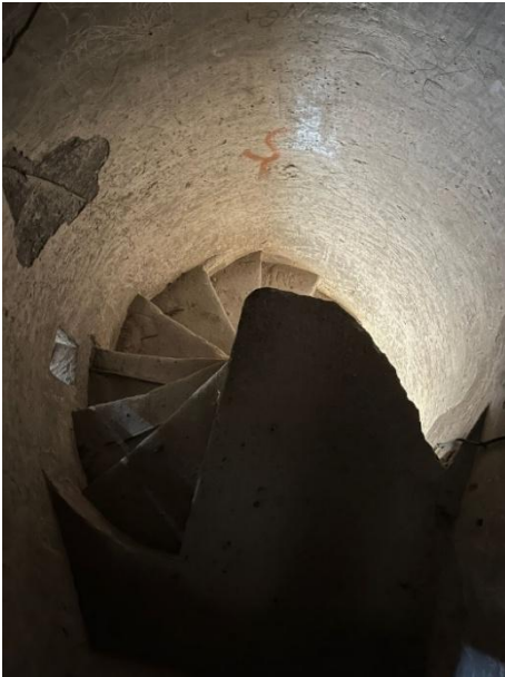
Şekil 11. Yıkılan merdivenin yenilenmesi
