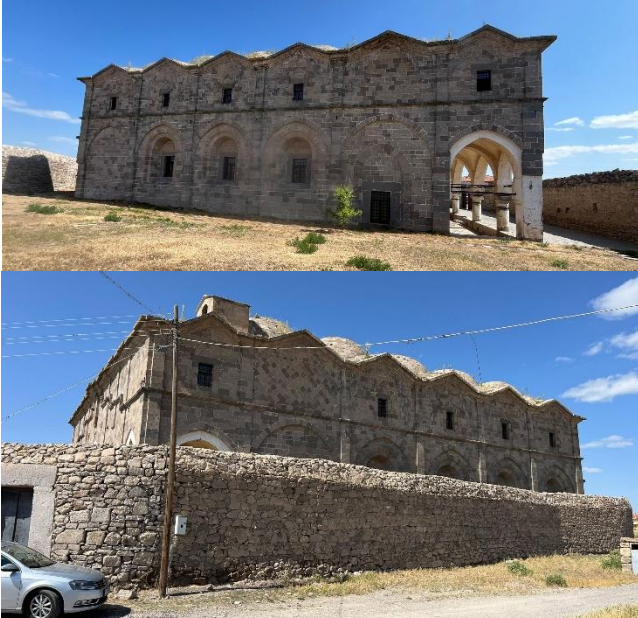
Şekil. 6. Konaklı Rum Kilisesi üstte kuzey cephe, altta güney cephe ve avlu duvarları
