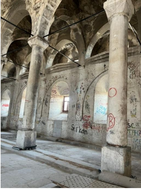
Şekil 10. Kilisenin taşıyıcılarında uygulanan betonarme bağ kiriş destekleri
