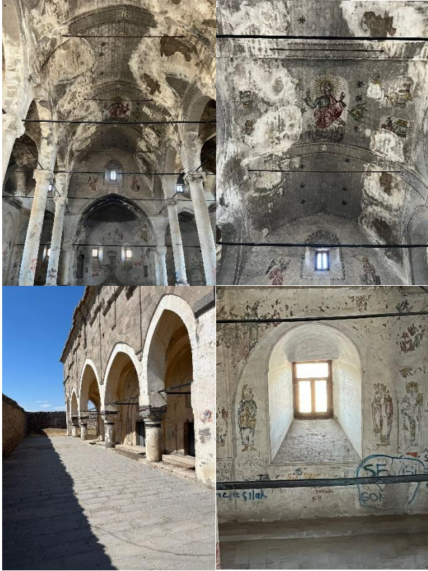
Şekil 9. Kilisede sırası ile: zeminde kullanılan taş kaplama, sütunlarda bulunan geç dönem Bizans süslemeleri, Silinmeye yüz tutmuş fresk izleri, giriş cephesinde bulunan kot farkı ve sivri uçlu kemer uygulaması, kemerli nişli pencere uygulaması
