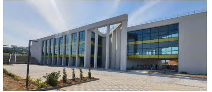
(Görsel-17 Mevcut Yapı)
