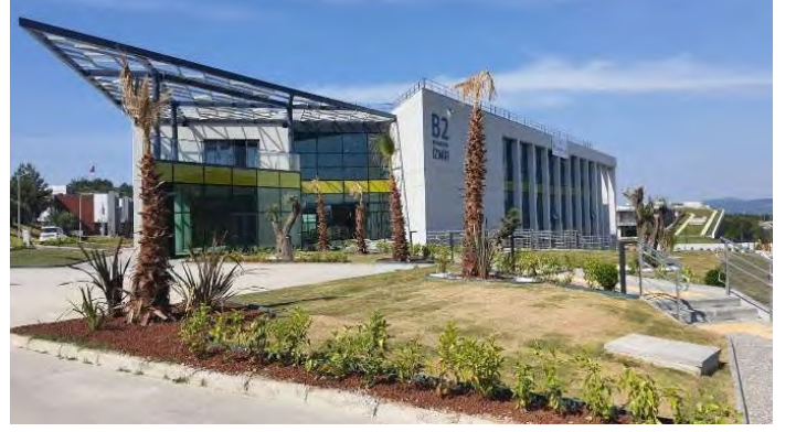
(Görsel-16 Mevcut Yapı)
